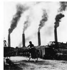
関西電力尼崎第一発電所(1956) 竹吉俊眞氏撮影
